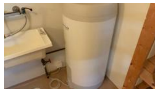
Varmtvannsbereider.
