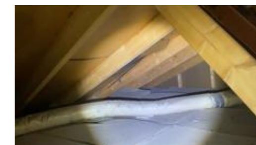
Løs/ødelagt sutaksplate.
