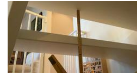
Større åpninger mellom opptrinn.
