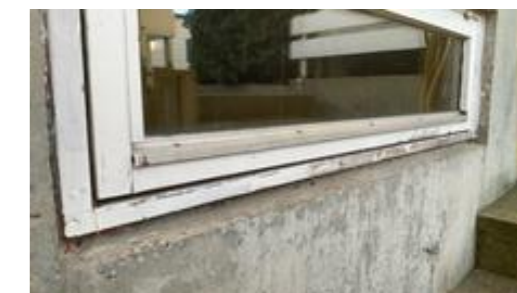
Vindu i kjeller.
