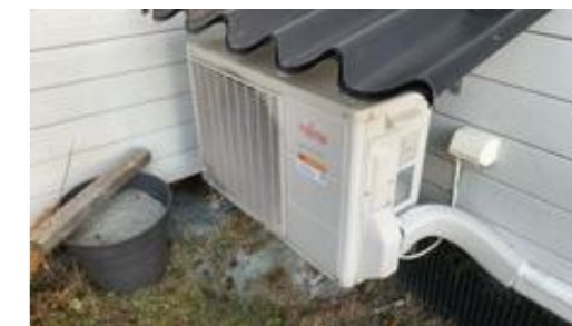
Varmepumpe utedel.
