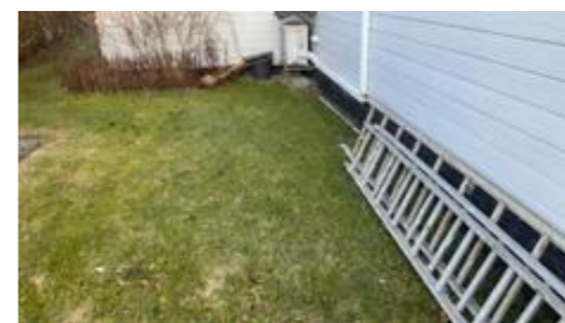
Terreng med fall mot mur.
