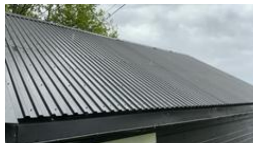
Taket er tekket med profilerte metallplater
