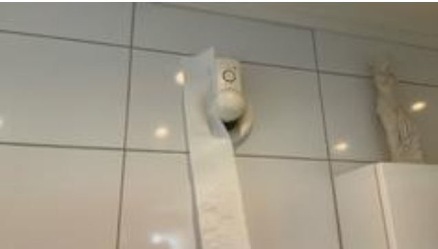
Vifte funksjonstestet med papir. 1 ETG > BAD
