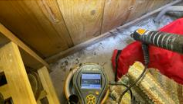
Fuktsøkt i vegg uten unormale forhold.
