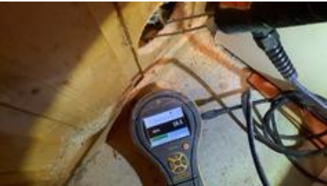
Fuktsøkt i vegg uten unormale forhold.
