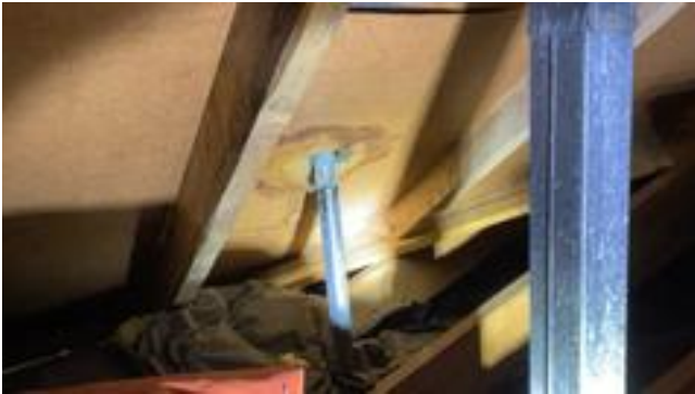
Lufting av avløpsanlegget over tak.
