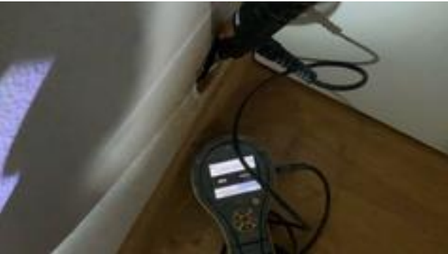
Fuktsøkt i vegg uten unormale forhold. UNDERETASJE > BAD
