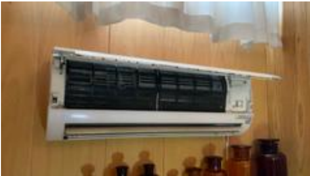
Varmepumpe innedel.
