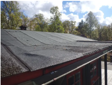
Flatere parti over inngangspartiet.
