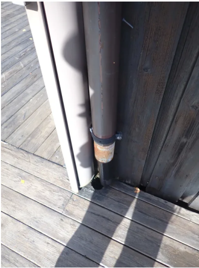
Bilde av nedløp som er avsluttet over terrasse.
