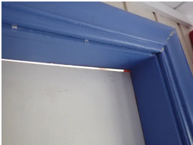
Eksempel på utettheter.
