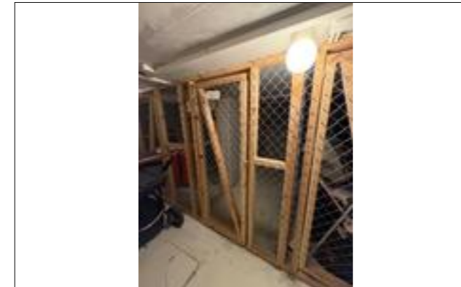
Kjellerbod nr 16-lav takhøyde 180 cm.
