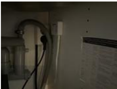
Lekkasjestopper er montert.
