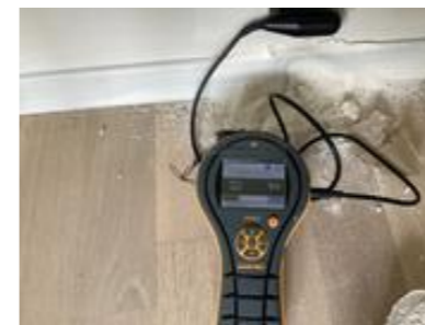
Hulltaking utført i vegg mot bad.
