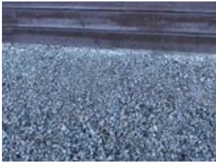
Liten avstand til bordkledning.
