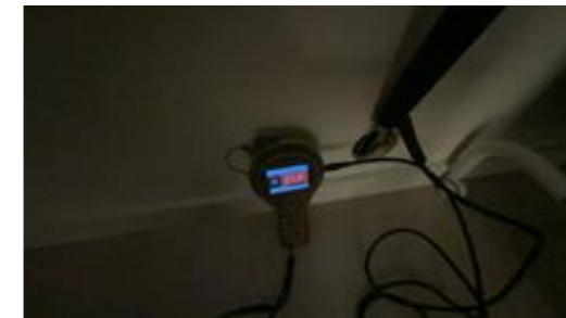
Fuktmålinger i vegg i stort rom.
