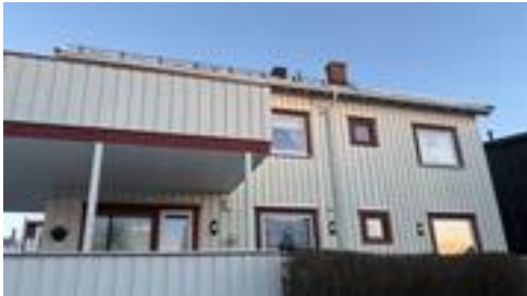
Bildet viser at det kun er etablert snøfanger på deler av taket og at det er en takstige som kun er festet med bøyle over mønet.
