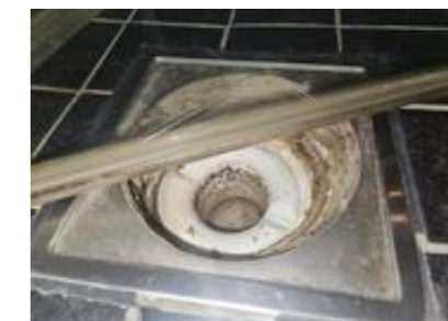
Plastluk med mansjett og klemring
