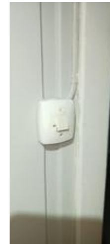
Bilde 1 1 etg. Gang. Knust deksel på bryter for lys i trapp.
