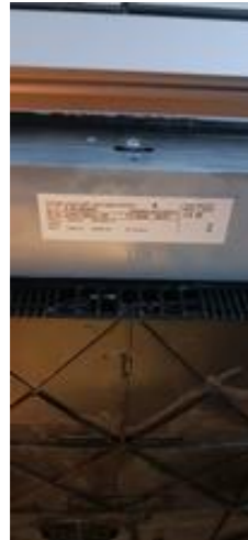
Bilde 1 Kabel til induksjon/platetopp (7200watt) er 4mm2 på 20amper sikring, denne bør være 25A og 6mm2 kabel.
