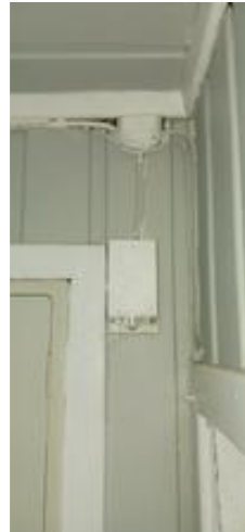
Bilde 1 1 etg. Gang. Opplegg for eldre ringeklokke-anlegg kan med fordel fjernes og erstattes av trådløs utgave.
