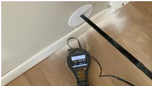
Fuktsøkt i vegg uten unormale forhold.
