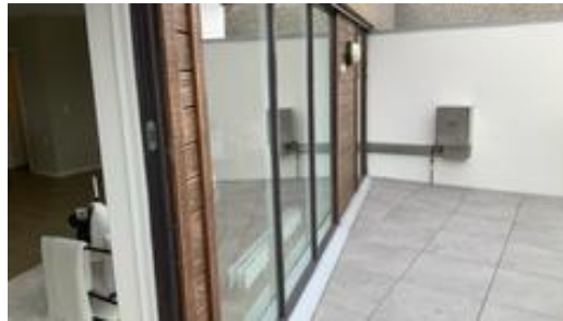
Vinduer fra byggeår.
