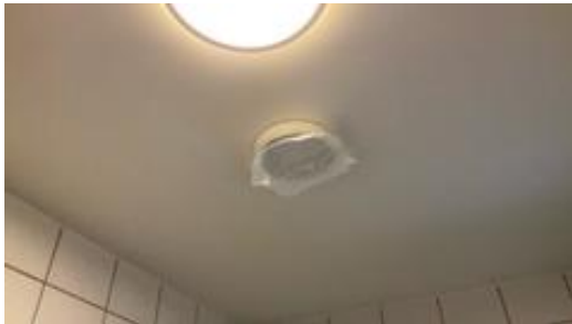
Avtrekk funksjonstestet med papir
