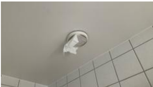
Avtrekk funksjonstestet med papir
