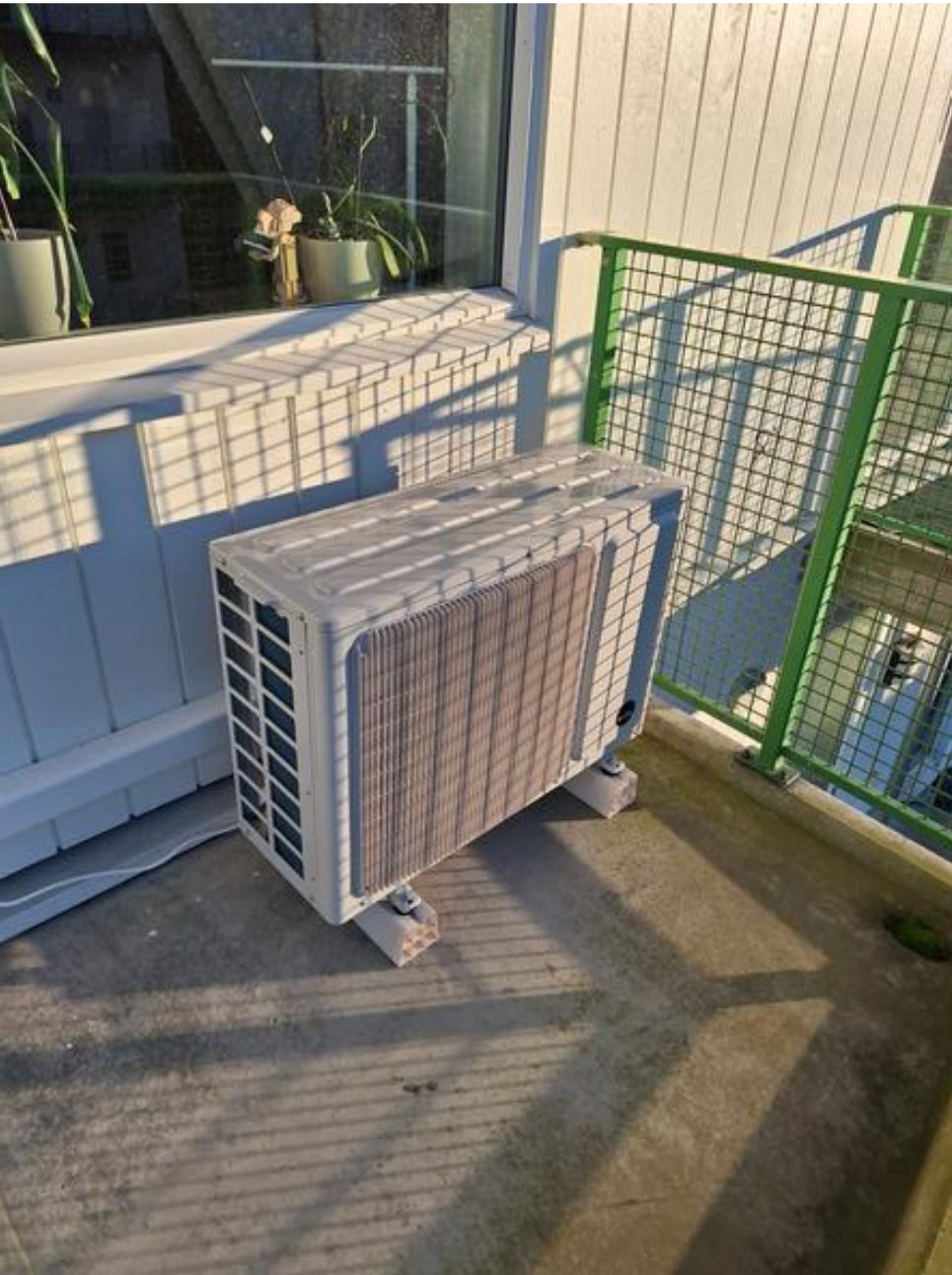
Vedlegg 3 til sak 6. Montering av varmepumpe
