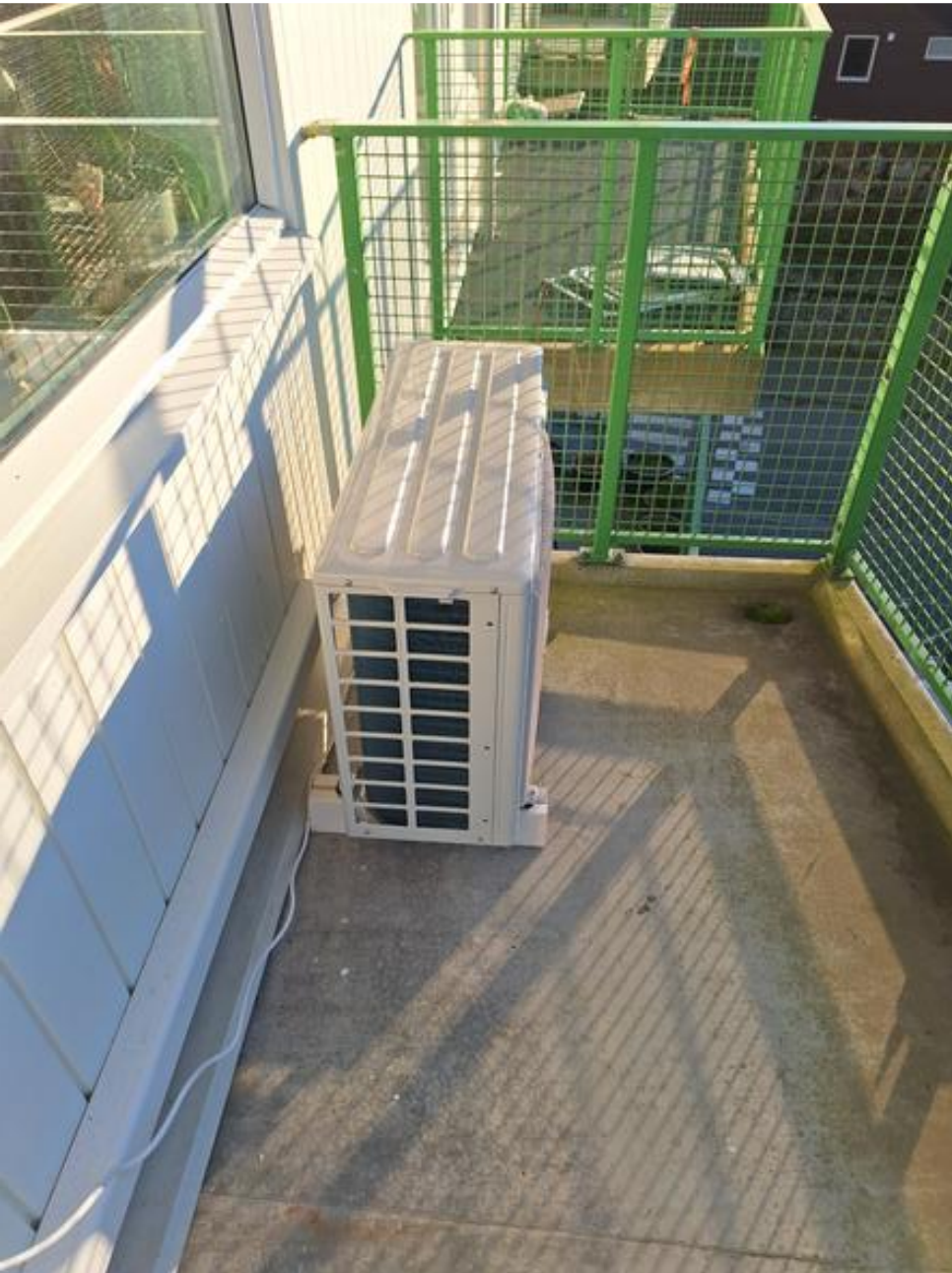
Vedlegg 2 til sak 6. Montering av varmepumpe
