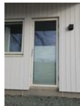
Verandadør 1 etg. Beslag under dørene er montert etter befaringen
