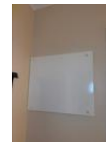
Rørskap på utsiden av baderom.
