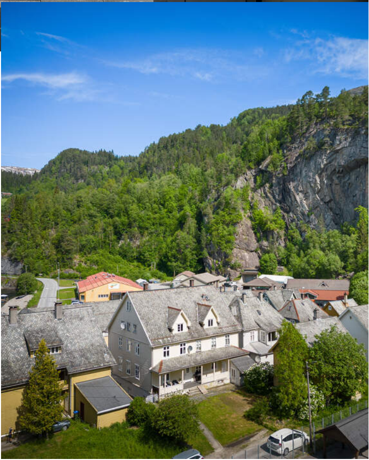
FELLES HAGE, TERRASSE OG UTEOMRÅDE PÅ BAKSIDEN AV BYGGET
