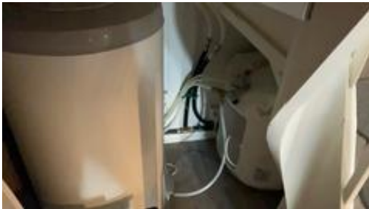
TG 2 Elektrisk anlegg
