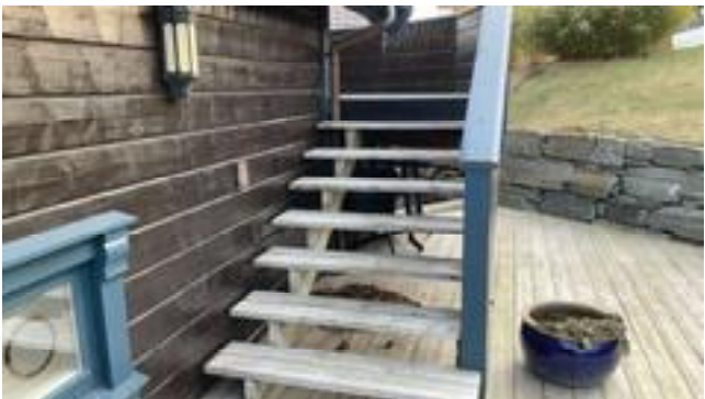
Trapp mot sør.
