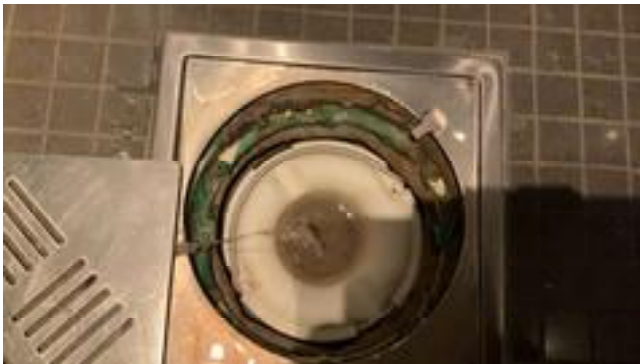
Sluk i gulv.
