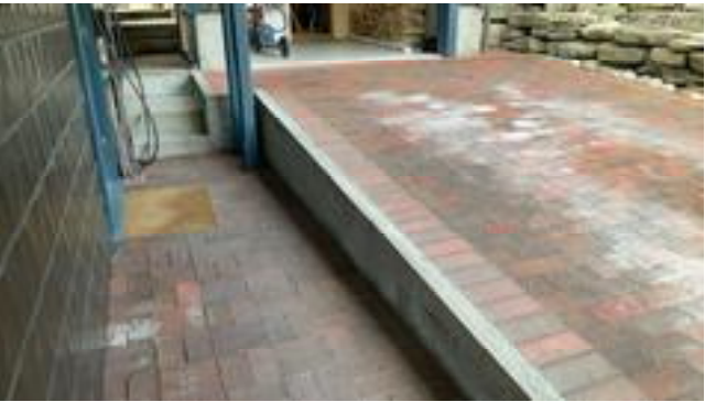
Forstøttningsmur mot garasje.
