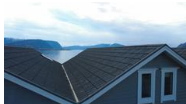
Taket er tekket med stålpanner
