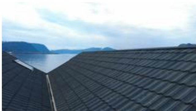
Taket er tekket med stålpanner
