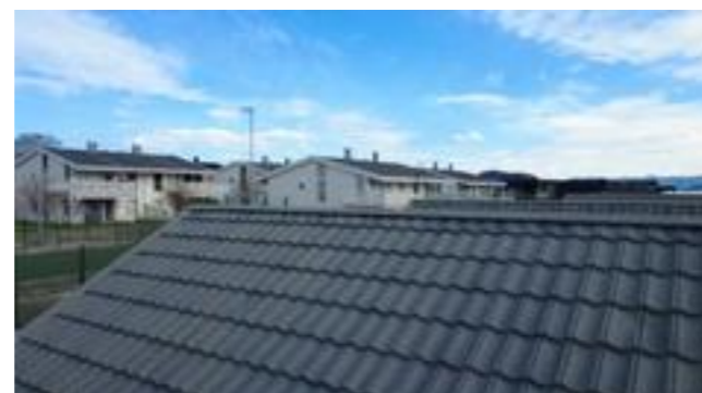
Taket er tekket med stålpanner
