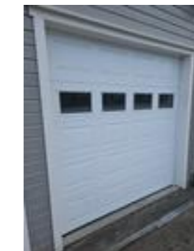
Leddport mot naustrommet
