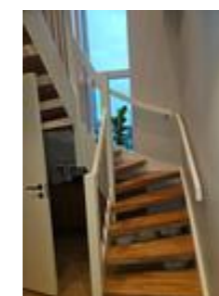
Innvendig trapp av tre mellom etasjene.
