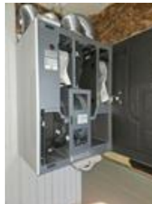
Balansert ventilasjon med varmegjenvinner
