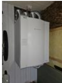
Balansert ventilasjon med varmegjenvinner
