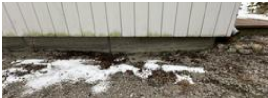
Ingen sprekk i grunnmur på utsiden.
