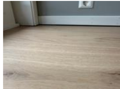
Glippe mellom gulv og fotlist/foring på dør.
