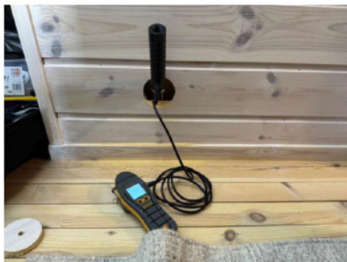
Bilde viser fuktmåling mot dusjsone
