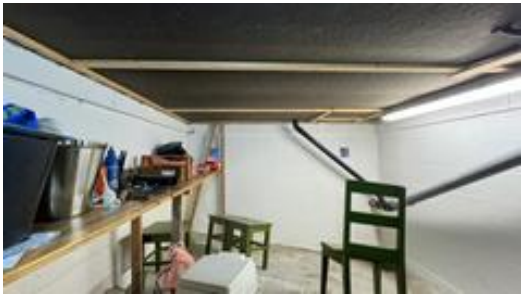
Oversiktsbilde av krypkjeller
