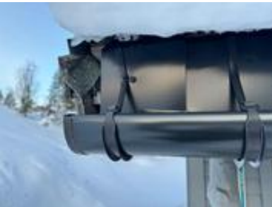
Bilde viser ufagmessig beslagsløsninger
