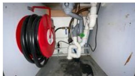
Avløp fra overløp er ikke tilkoblet.
