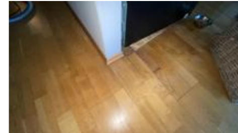
Eldre fuktskader i gulvet.
