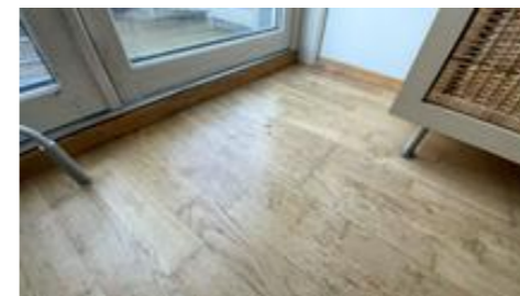
Eldre fuktskader i gulvet.
