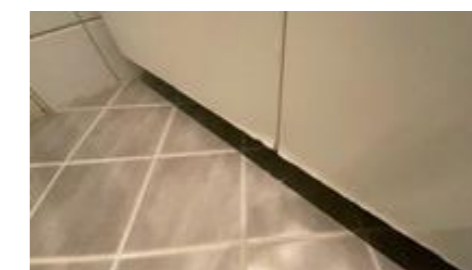
Fuktskader
