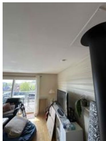
Bilde 1 Detektor i stue er ca 46cm fra nærmeste vegg.
