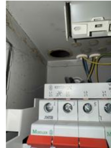
Bilde 1 Åpningen måles til ca. 40mm
