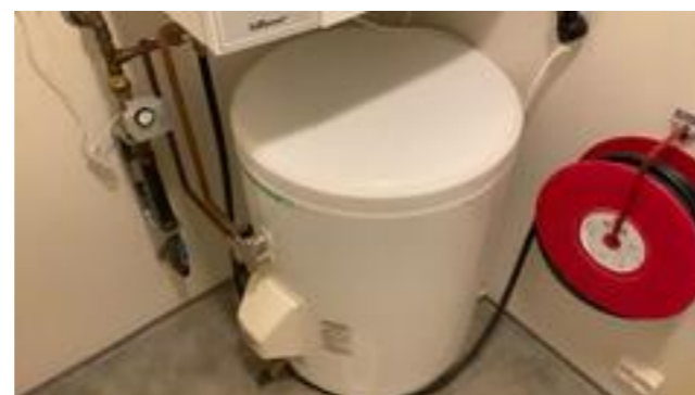
Varmtvannsbereder.
