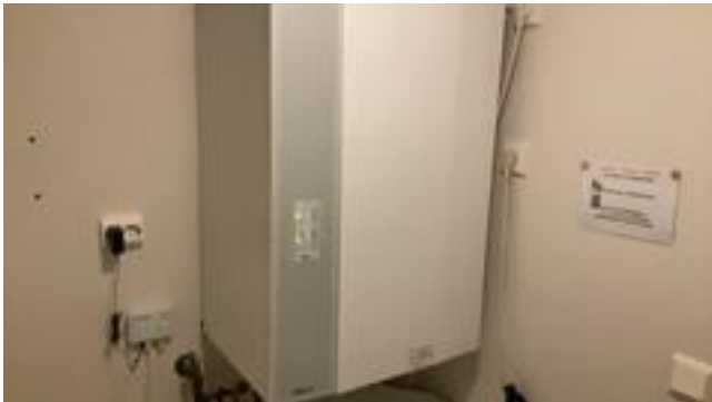
Motor for ventilasjonsanlegget.
