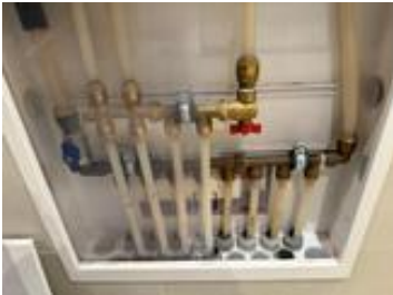
Rørkursene på rør-i-rør systemet på vannledninger er ikke merket.
