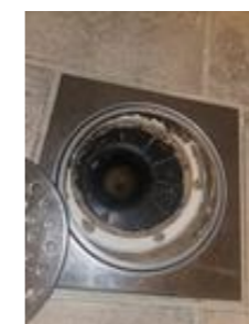
Plastsluk med mansjett og klemring
