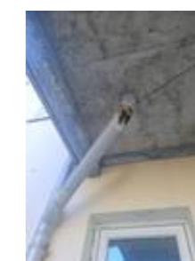
Rust på nedløpsrør fra veranda 3 etg skyldes trolig at nedløp av zink er festet med ståltråd. Ikke synlig lekkasje men bør utbedres.
