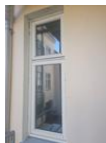
Vinduene har karmen av tre og isolerglass
