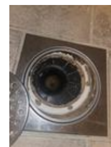
Plastsluk med mansjett og klemring
