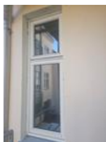
Vinduene har karmen av tre og isolerglass
