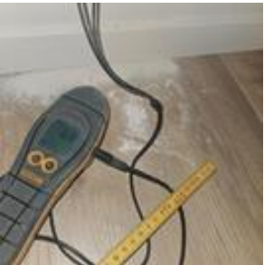
Ingen indikasjon på unormal fukt i veggen
