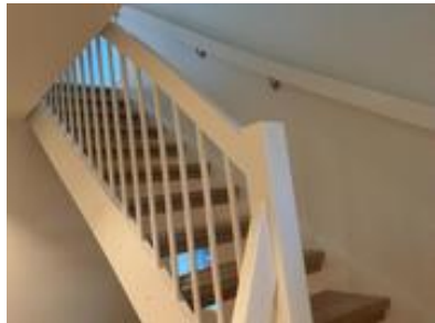
Innvendig trapp av tre mellom etasjene.
