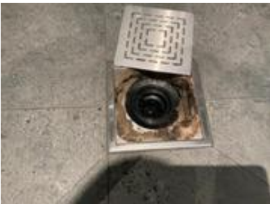
Plastsluk med slukmansjett og klemring. I dusjen
