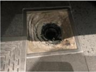
Plastsluk med slukmansjett og klemring. Utenfor dusjen
