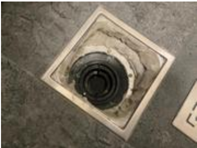
Plastsluk med slukmansjett og klemring
