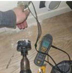
Ingen indikasjon på unormal fukt i veggen
