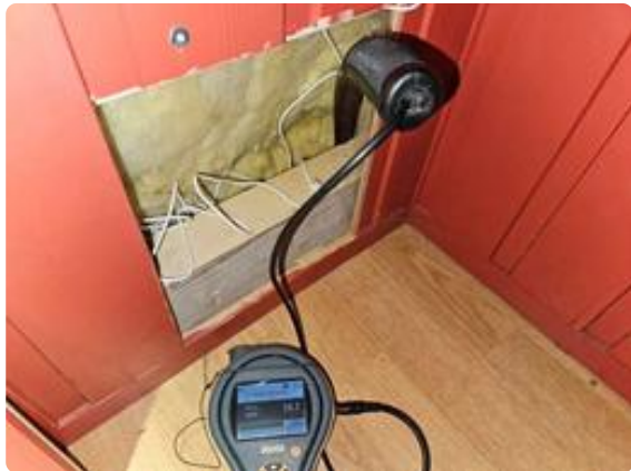
Fuktmåling utført fra luke under trapp.
