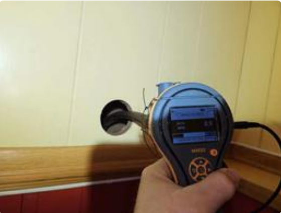
Fuktmåling utført fra trapp.
