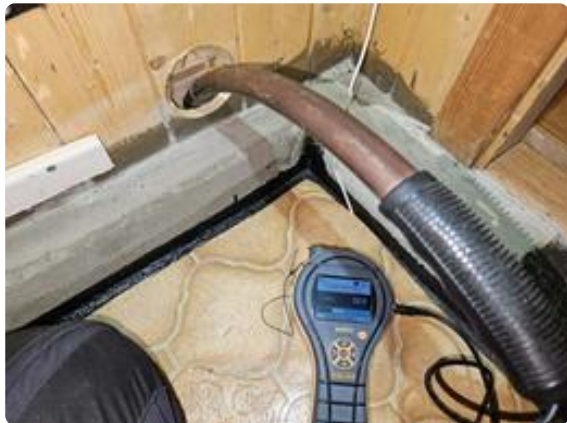
Fuktmåling fra teknisk rom.
