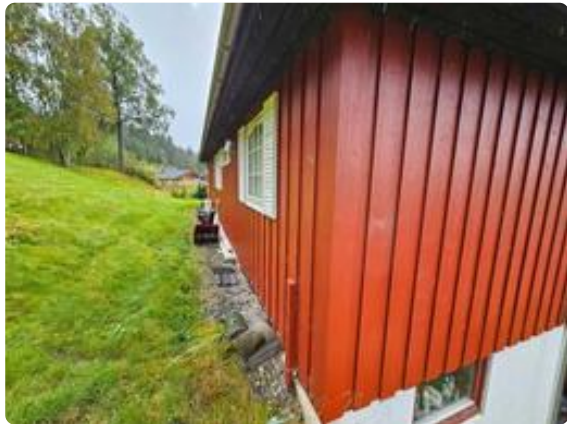
Skrående terreng mot boligen, men drenerende masse ca. 1 meter ut fra grunnmur.
