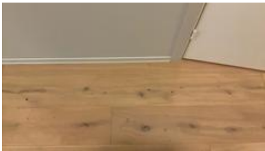
Parkett og malte vegger
