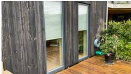
Fabrikkmalte vinduer fra byggeår.
