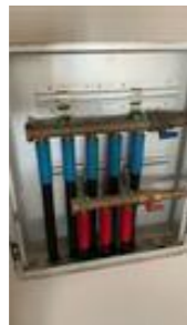
Fordelingskap for tappevann med stoppekraner
