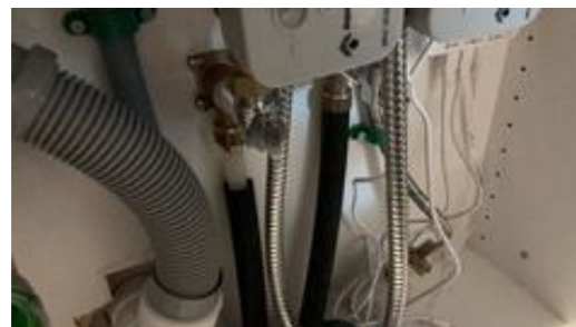
Fordelingskap for tappevann med stoppekraner
