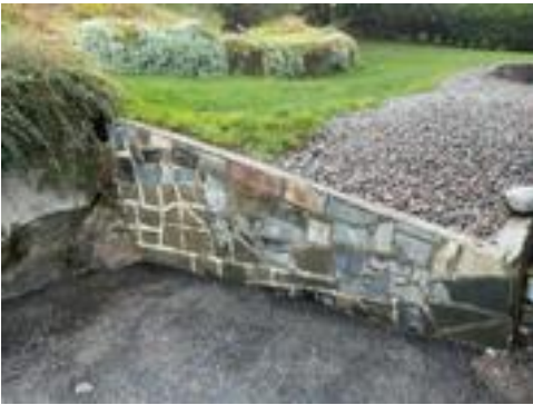
Støttemur av sparesteinsmur
