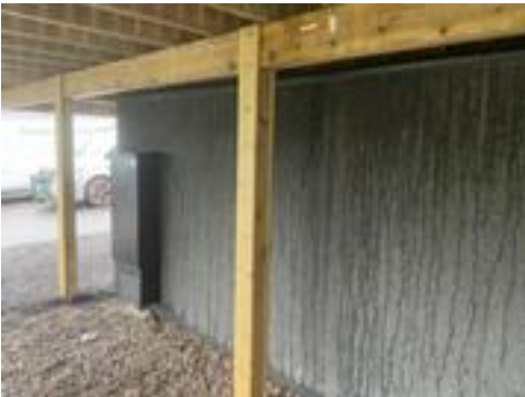
Grunnmuren er kledd med sementbaserte fasadeplater på utsiden
