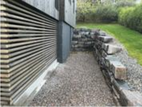
Støttemur av naturstein
