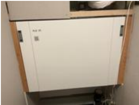
Balansert ventilasjon med varmegjenvinner
