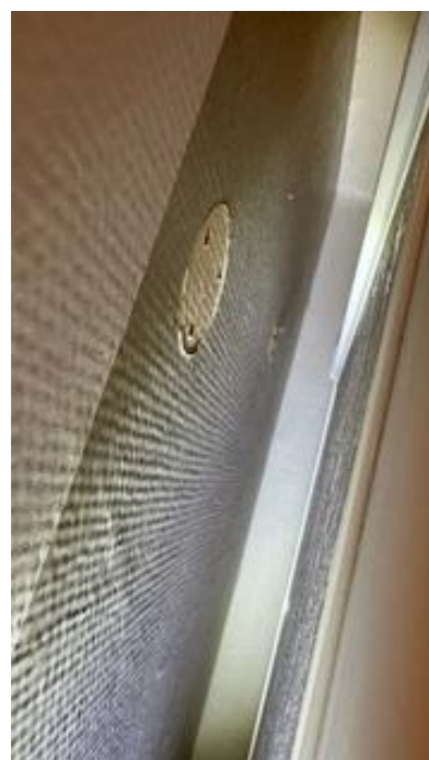
Eksempelbilde av åpninger/ monteringshull i vegg bak dusjkabinett.
