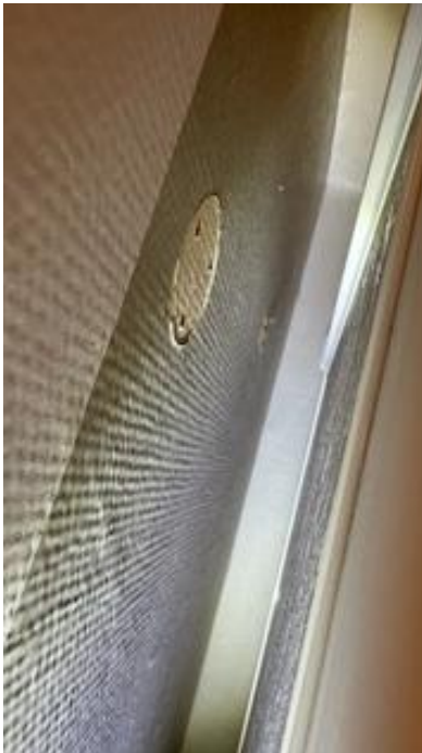
Eksempelbilde av åpninger/ monteringshull i vegg bak dusjkabinett.
