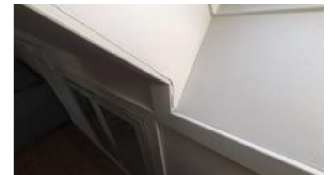
Eksempel på mindre sprekker som er definert som TG1.
