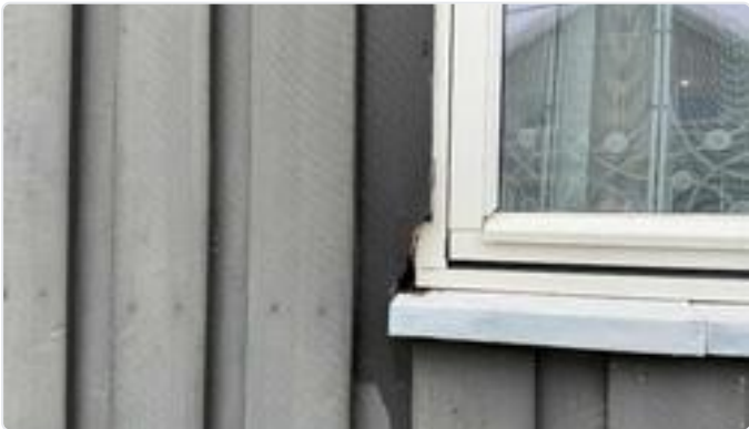
Råteskadet treverk.
