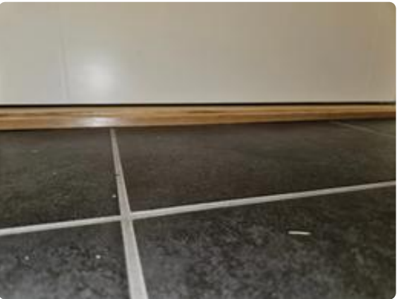
Minimalt med spalte under dørblad for tilførsel av luft til rommet.
