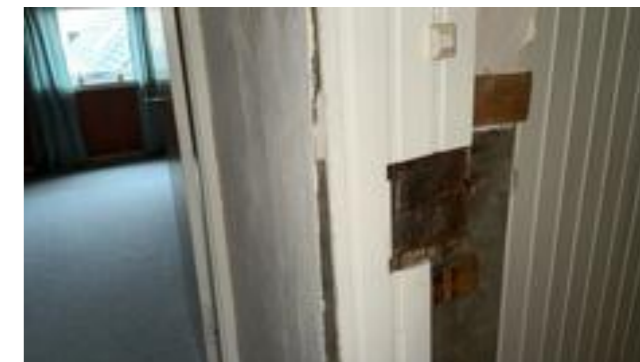
Pipevange er kledd inn.
