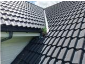
Mosegroing./gressgroing på taktekking/beslag
