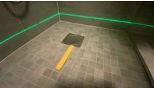
Det er ikke etablert tilstrekkelig fall på gulv mot sluk i dusjnise.
