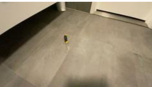
Det er registrert "bom"/manglende limdekning under enkelte fliser på gulv.
