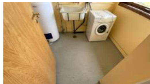
Vaskerom fra byggeåret.
