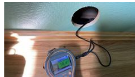
Hulltaking er foretatt i vegg fra tilstøtende soverom
