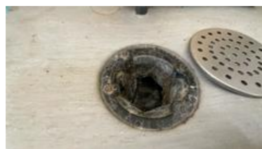
Plastsluk i gulv og vinylbelegg fra byggeåret.
