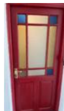
Original dør mot trapperommet
