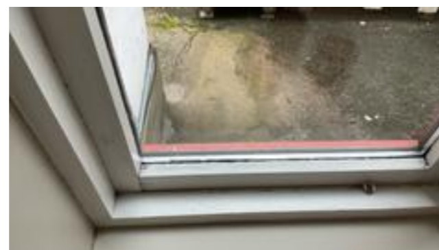
Spor etter kondens på et vindu på badet
