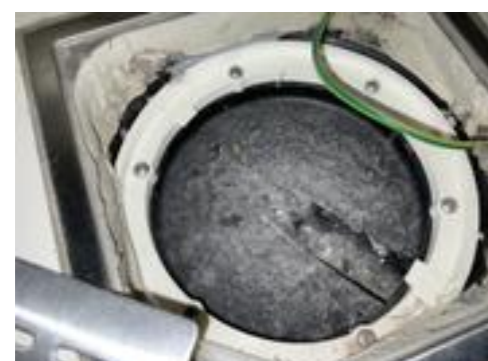
158 2.ETASJE > BAD/WC-2 EILERT SUNDTS GATE 42A
