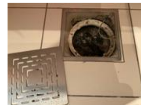
Hjelpesluket under servanten.
